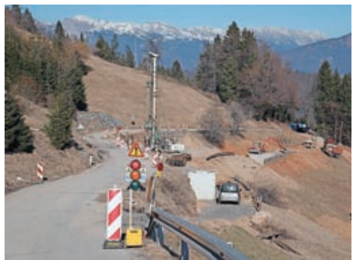
Na regionalni cesti blizu Lajš poteka sanacija plazua in nasipne brežine.
