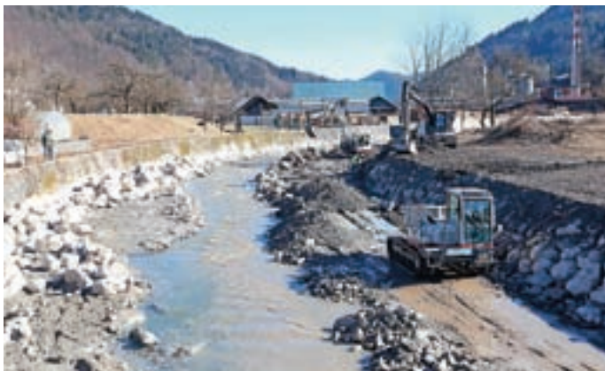
Podbetoniranje obrežnih zidov in zavarovanje brežin na odseku med Alplesom in Domelom
